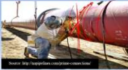
पाइप लाइन में वेल्डिंग / Welding in pipelines
