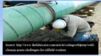
विषम अवस्था में वेल्डिंग / Awkward welding positions
