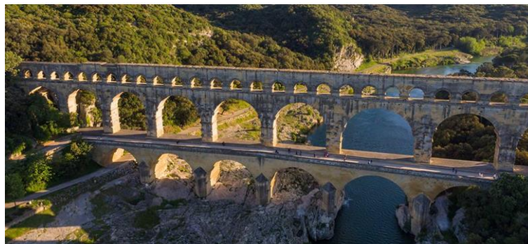
Figure 4 Pont du Gard (40-60AD)
